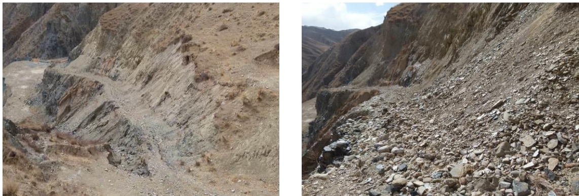
施工场地恢复植被
