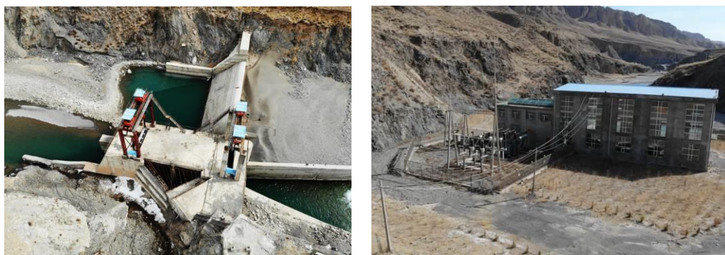
图 2.7-1 党村水电站工程坝址及厂房
